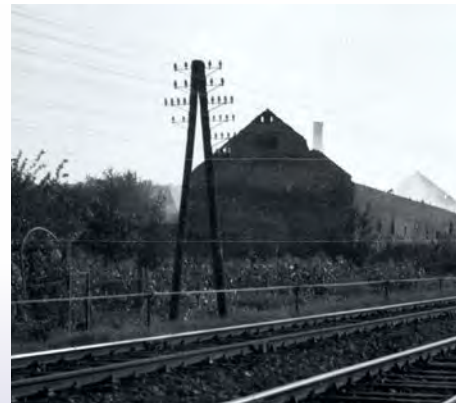
Budova panského dvora bez střechy po požáru
