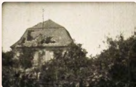
Sokolovna - poškozená střecha
