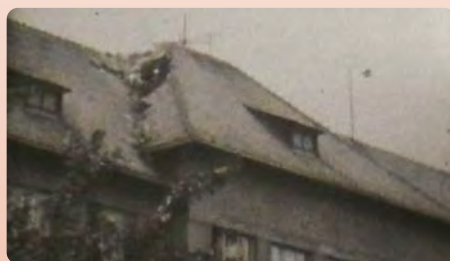
2. stupeň ZŠ v Komenského ulici - poškozená střecha
